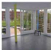
aanbouw, schuifpuien, kozijnen.
